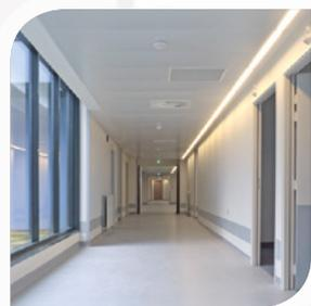
Des systèmes ouvrants basculants ou coulissants, pour chaque utilisation spécifique. C'est la solution plafond adaptée aux circulations des bâtiments tertiaires avec besoins particuliers. Les profils sont visibles.
